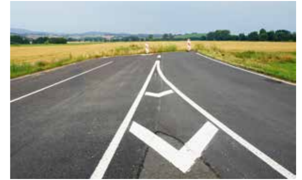
Unfertige Bundesstraße südlich von Eisenach (Thüringen)
