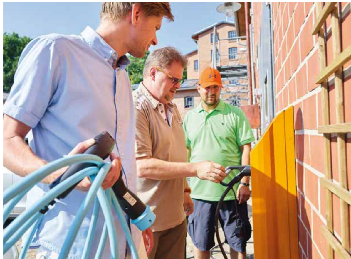
Installation einer neuen Ladestation für E-Mobilität auf Usedom (Mecklenburg-Vorpommern), 2016
