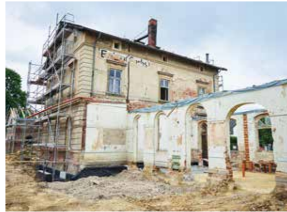
Baustelle des Generationenbahnhofs in Erlau (Sachsen), 2015
